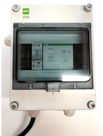
Fot. 1. Skrzynka sterownicza z podłączonym pływakiem
